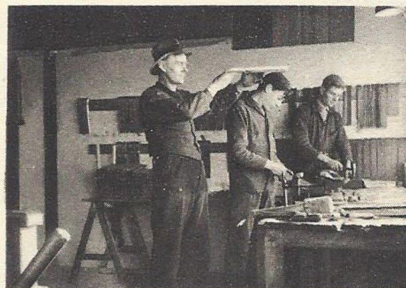
Het monteren der ijzers in de houten
